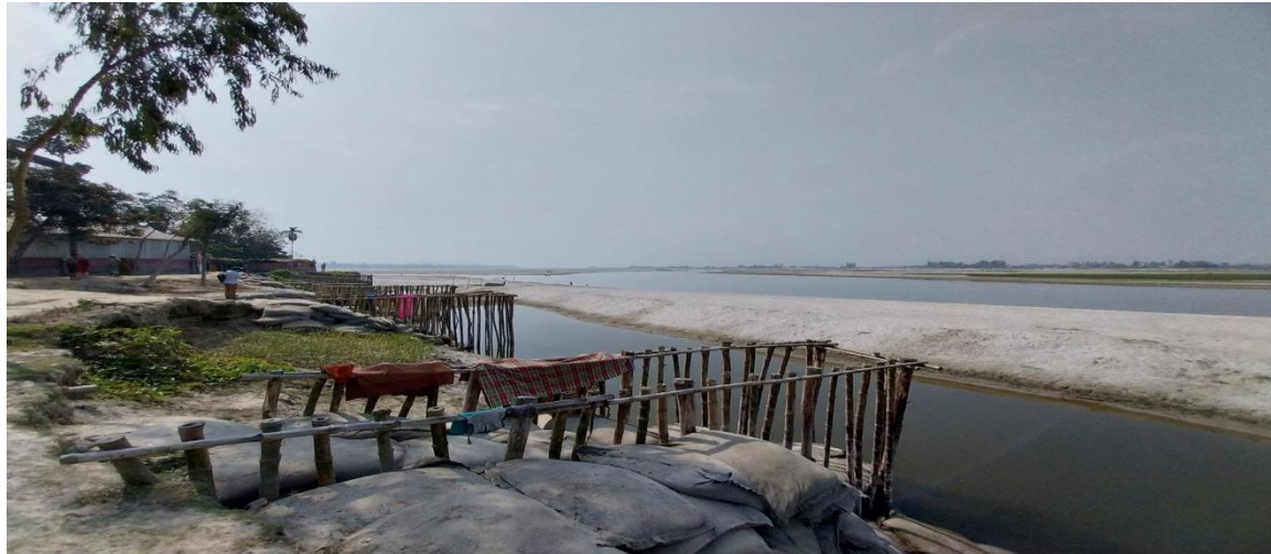
PictureFig. 5. Bamboo fencepiling/Bundal(Daldalia)
